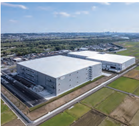
25年2月に新設した「猿ヶ島センター」では常温(ドライ)商品と冷蔵(チルド)商品を同時に配送する(ハイブリッドセンター)
